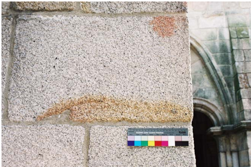
Figura 20. A mancha circular que se encontra junto ao limite superior do bloco de pedra assemelha-se às observadas na fachada norte
