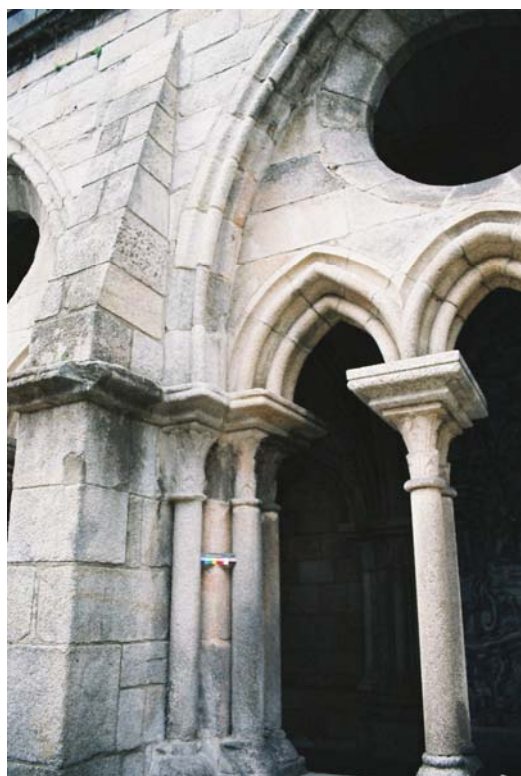
anexados ao contraforte.
