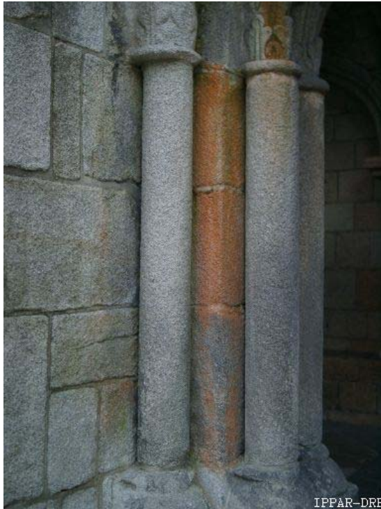
Figura 23. Pormenor da alteração cromática, em período de chuva.
