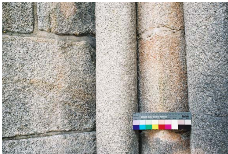
Figura 21. A área considerada alterada, P.1, entre as duas colunas; a coluna imediatamente a seguir, à esquerda considerada como a área não alterada, P.0..
