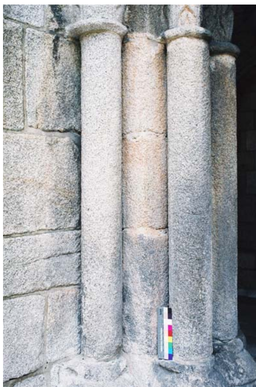
Figura 17. A alteração cromática presente na região
