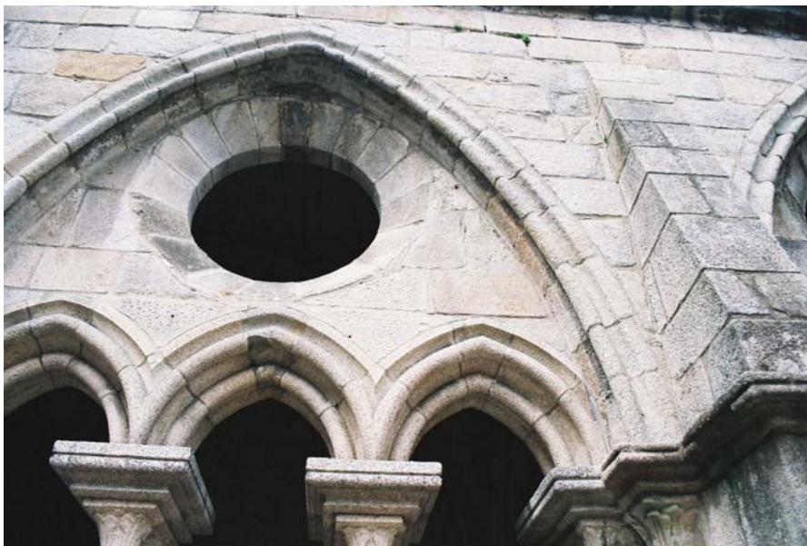
Figura 18. Na fachada norte, sobre a segunda grande arcada ogival, à direita, assiste-se ao surgimento da alteração cromática.
