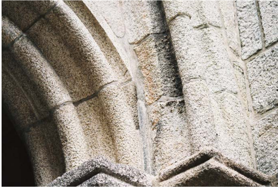
Figura 19. Pormenor da alteração, sobre o cruzamento dos arcos ogivais.
