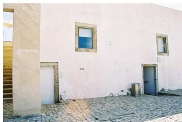
Figuras 26 e 27. O corpo D dos Edifícios da Correnteza, Fortaleza de Sagres. A escadaria dá acesso ao piso superior; a porta que está aberta (direita), às casas de banho.
