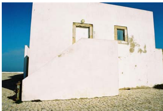
Figuras 28 e 29. Pormenor da escadaria que dá acesso ao piso superior do corpo D (à esquerda); a fachada virada a oeste do corpo D (à direita). Em ambas as figuras se observa a alteração da cor branca para rosa (tinta - materiais industriais/recentes).
