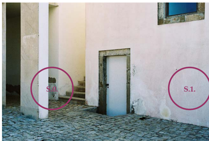
Figura 31. As áreas S.0. e S.1. onde se efectuaram as medições dos parâmetros de cor, no corpo D.
